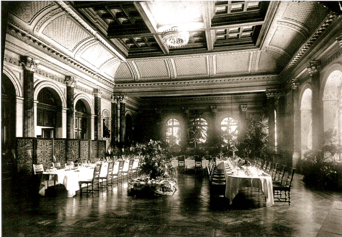
Hergerichtet für das Staatsbankett mit dem Deutschen Kaiserpaar: Hotel Schweizerhof, Grosser Saal, erbaut 1864/65. Fotografie 1893. (SALU F2a/Strassen/Schweizerhofquai 4)
