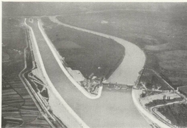
Abb. 77. Oberwasserkanal und Stauwehr Kembs.
