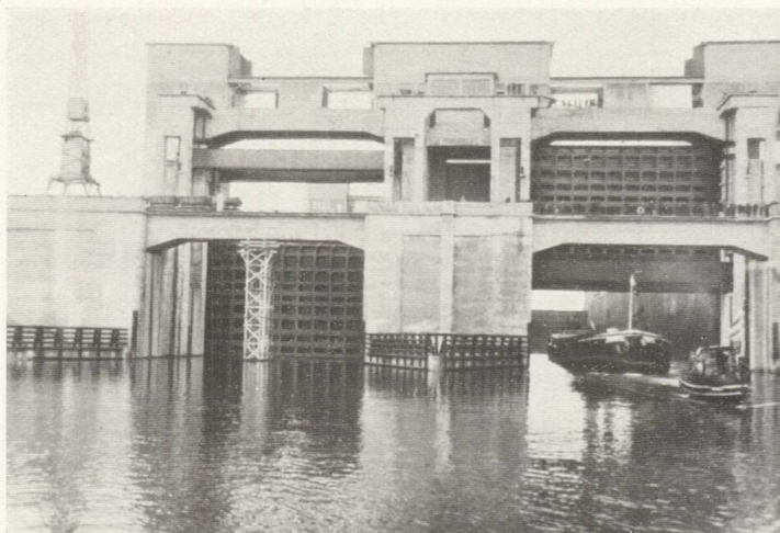
Abb. 79. Grossschiffahrtsschleuse bei Kembs.
