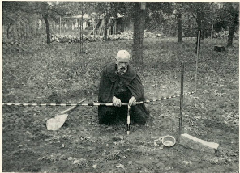
Bild 16 Einmessen eines Grenzpunktes
