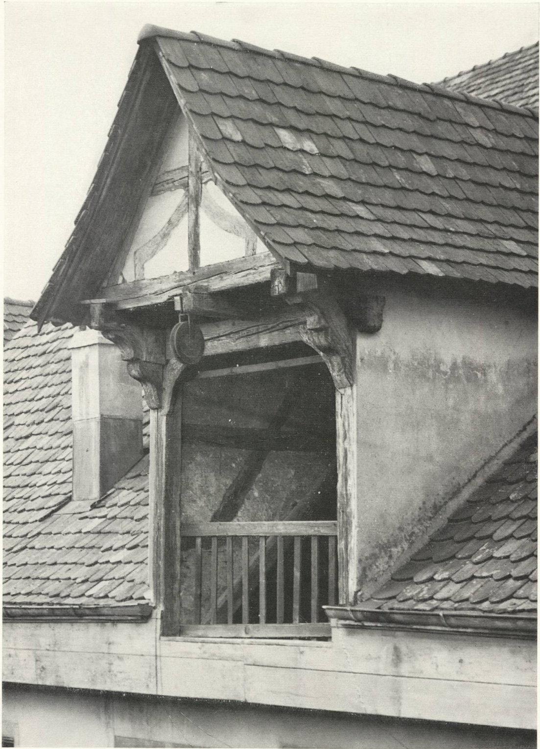
2 Dachaufbau eines gotischen Hintergebäudes in Liestal
