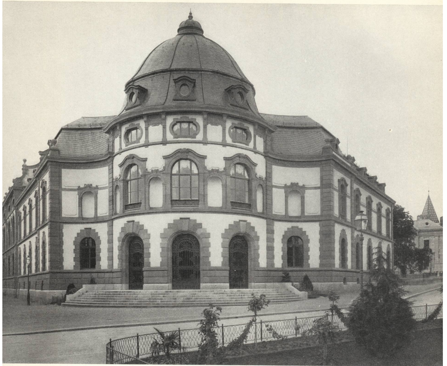
11 Der 1965/66 abgebrochene Teil der Universitätsbibliothek
