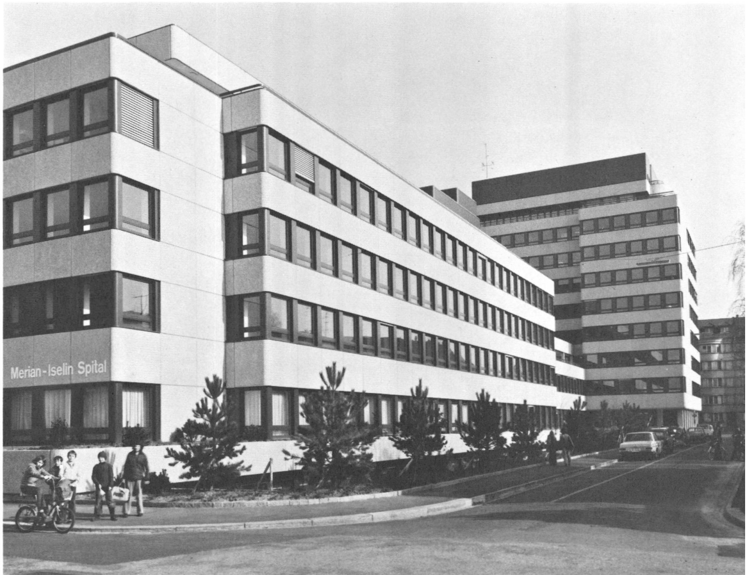
Neubau des Merian-Iselin-Spitals, Föhrenstraße 2, 1976
