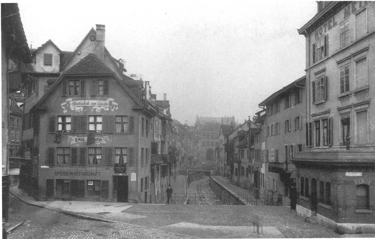
Abb. 29 Vorläufige Teil-Überwölbung des Birsigs, 1888–1899.
