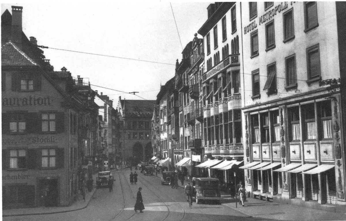
Abb. 30 Endgültig überwölbter Birsig.
