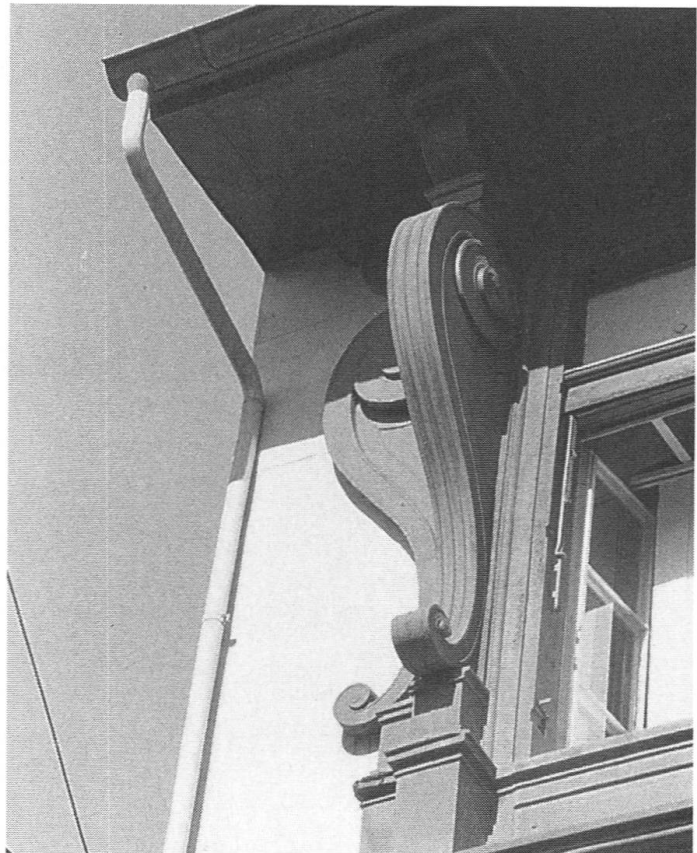
Abb. 19 «Spiesshof», Renaissancebau, 3. Obergeschoss, Fenster mit Volutenkonsolen
