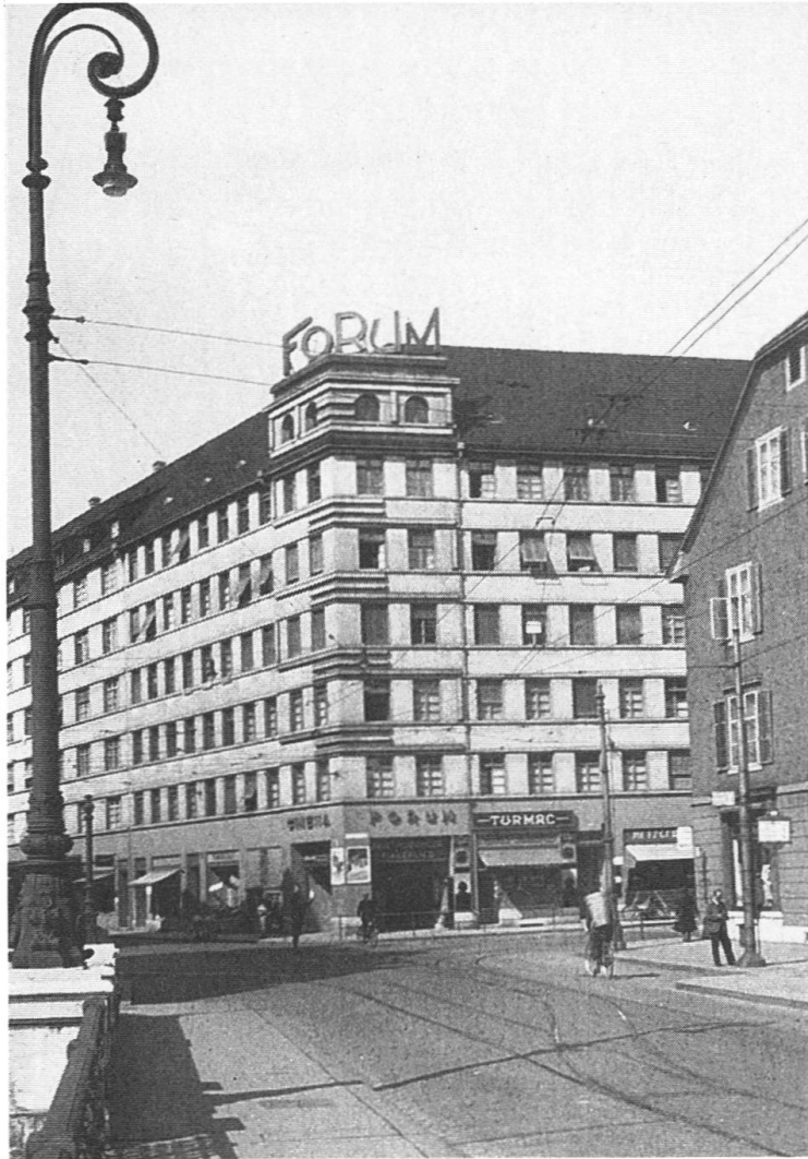
Abb. 36 Das Forum wurde in ein Wohn- und Geschäftshaus integriert.
