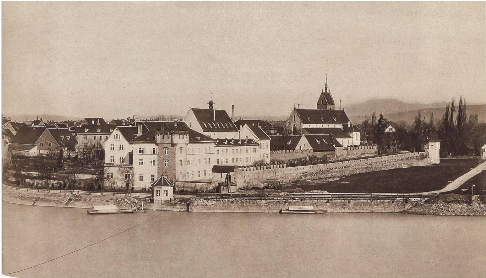
Abb. 6 Waisenhaus mit einem Teil der Stadtbefestigung und der Herrenmatte (heute Brückenkopf der Wettsteinbrücke) (Fotografie vor 1876).
