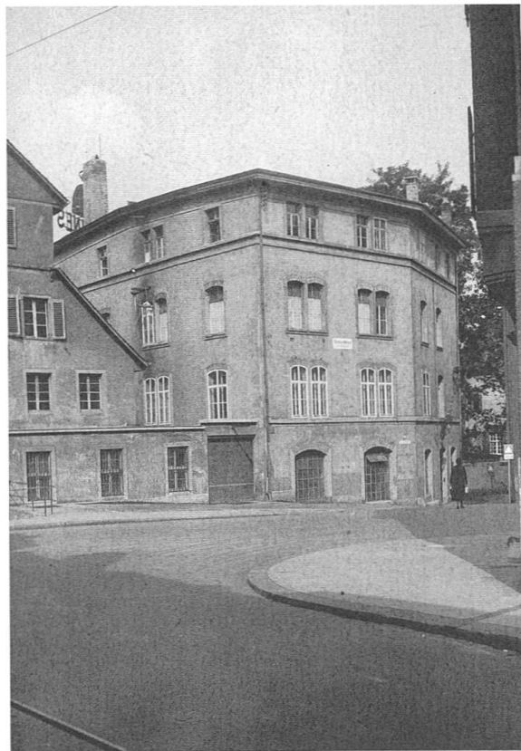
Abb. 10: «Eisfabrik» an der Unteren Rheingasse, 1895–1910 Domizil der Chemischen Anstalt (Abteilung II), Photographie um 1938 (StABS, Bildersammlung Neg 8035).
