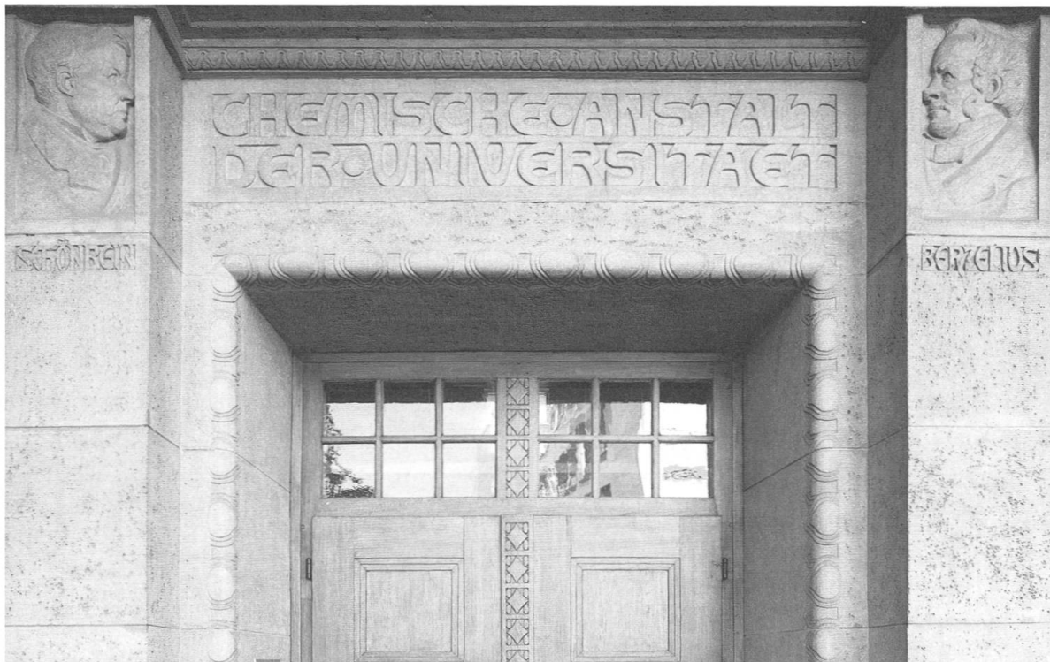
Abb. 12: Chemiegebäude an der Spitalstrasse, Portal mit Reliefdarstellungen von Christian Friedrich Schönbein und Jöns Jakob Berzelius, 1910, Photographie 2011.
