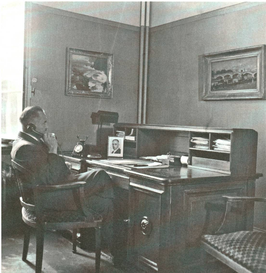
Abb. 26: Dr. Max Fluri, Direktor der FAS von 1926 bis 1941, im Direktionszimmer. Heute befindet sich hier das Büro der Leitung Verwaltung.
