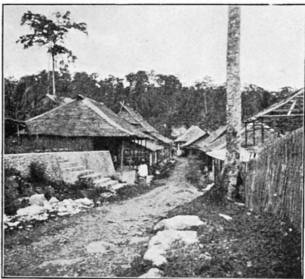
Marktstrasse zugleich Hauptstrasse von Fakfak.
