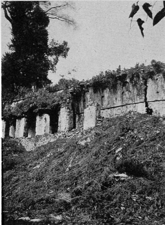
Abb. 2. Halle im Palastgebäude in Palenque. Pfeiler-vorhalle, teilweise zerstört. Auf dem Dach ein gewaltiger Baum als Rest früheren Bewuchses der Ruinen. Im Vordergrund frisch niedergelegter Bewuchs. Aufnahme F. TERMER, 1926
