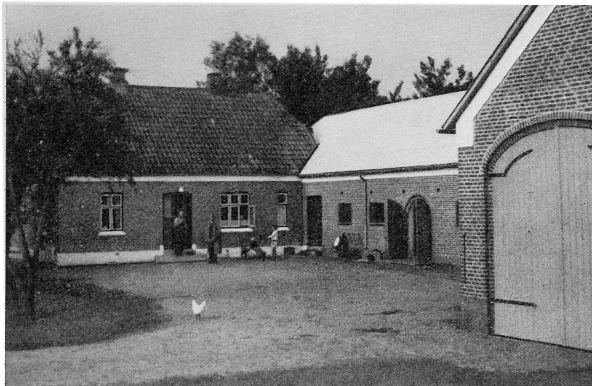
Dänischer Bauernhof. Typische Hufeisenanlage von Wohntrakt, Stall und Scheune. Größere Husmaend-Stelle von zirka 8 ha. An der Westküste häufiger in Backstein, an der Ostküste Fachwerk mit Kalkverputz. Photo E. RAUCH
