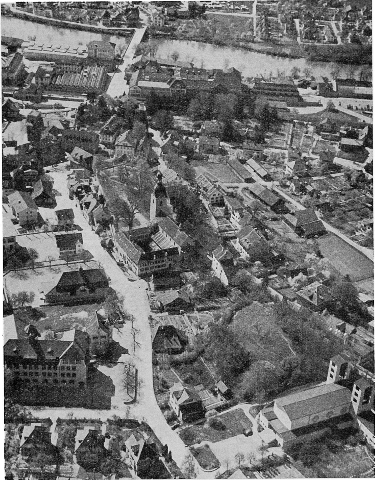
Abb. 33 Blick nach W auf das älteste Siedlungsgebiet von Schönenwerd. Vorn die katholische Kirche und der Schulgartenhügel, wo jungsteinzeitliche Funde gemacht wurden. In der Bildmitte der „Bühl“ mit dem ehemaligen Chorherrenstift, das heute als christkatholische Kirche benützt wird
