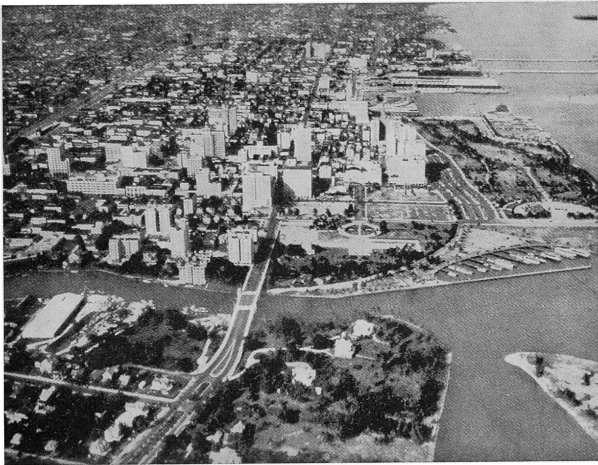
Abb. 2 Blick von S auf Miami Downtown, im Mittelgrund von rechts nach links: Bayfront-Park, Hotelfront, Geschäftsviertel, FECRR-Bahnhof. Im Vordergrund Miami River und Brücke der Miami Avenue, die sich nach N zieht. Im Hintergrund beim Hafen Miami die Mündung der beiden Causeway von Miami Beach
