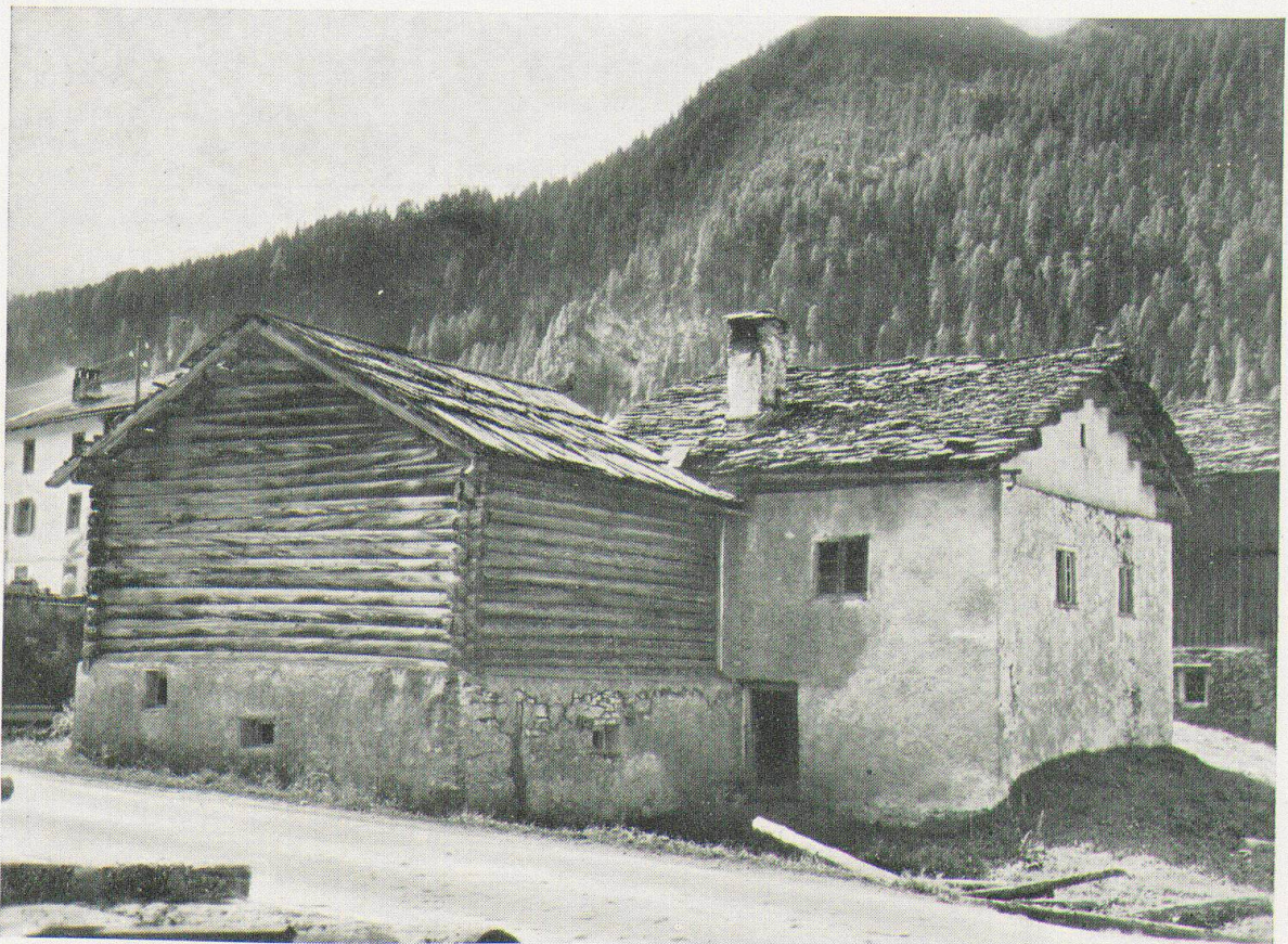
Wohnhaus mit angebautem Heustall in Cresta. Das Wohnhaus ist zweigeschoßig, mit Steinplatten gedeckt; der Stall aus verputztem Mauerwerk trägt den Heuraum, einen Rundholzblockbau mit altem Bretterdach
