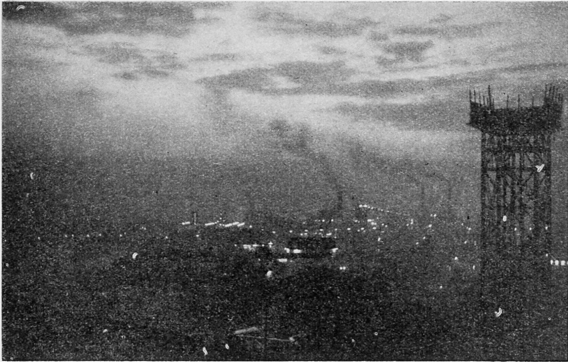
Bochum am Abend. Das Bild einer tätigen Ruhrindustriestadt beim Einnachten, aufgenommen von der Gicht eines Hochofens. Rauch und Nebel verschleiern gemeinsam die Lichter von Lampen, Scheinwerfern und glühenden Schmelzöfen. Aufnahme: W. KUHN
