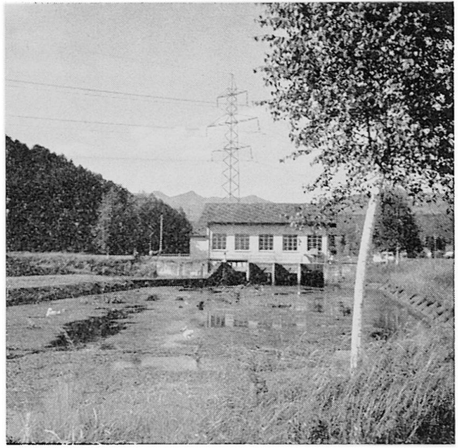
Abb. 9 In der Pumpanlage Grinau entwässern zwei vollautomatisch gesteuerte Pumpen ein 522 ha großes Einzugsgebiet; sie fördern das Wasser 2.10 m hoch.
