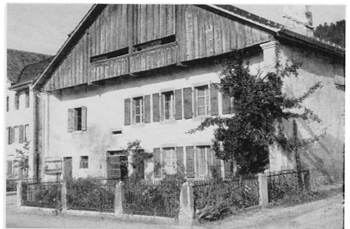
Photo 2. Ferme-pignon de Dombresson à tripartition longitudinale du rez-de-chaussée: étable, fourragère et logement. Brise-vent à chaque extrémité de la façade. Fentes d'aération de la grange aménagées dans la façade-pignon
