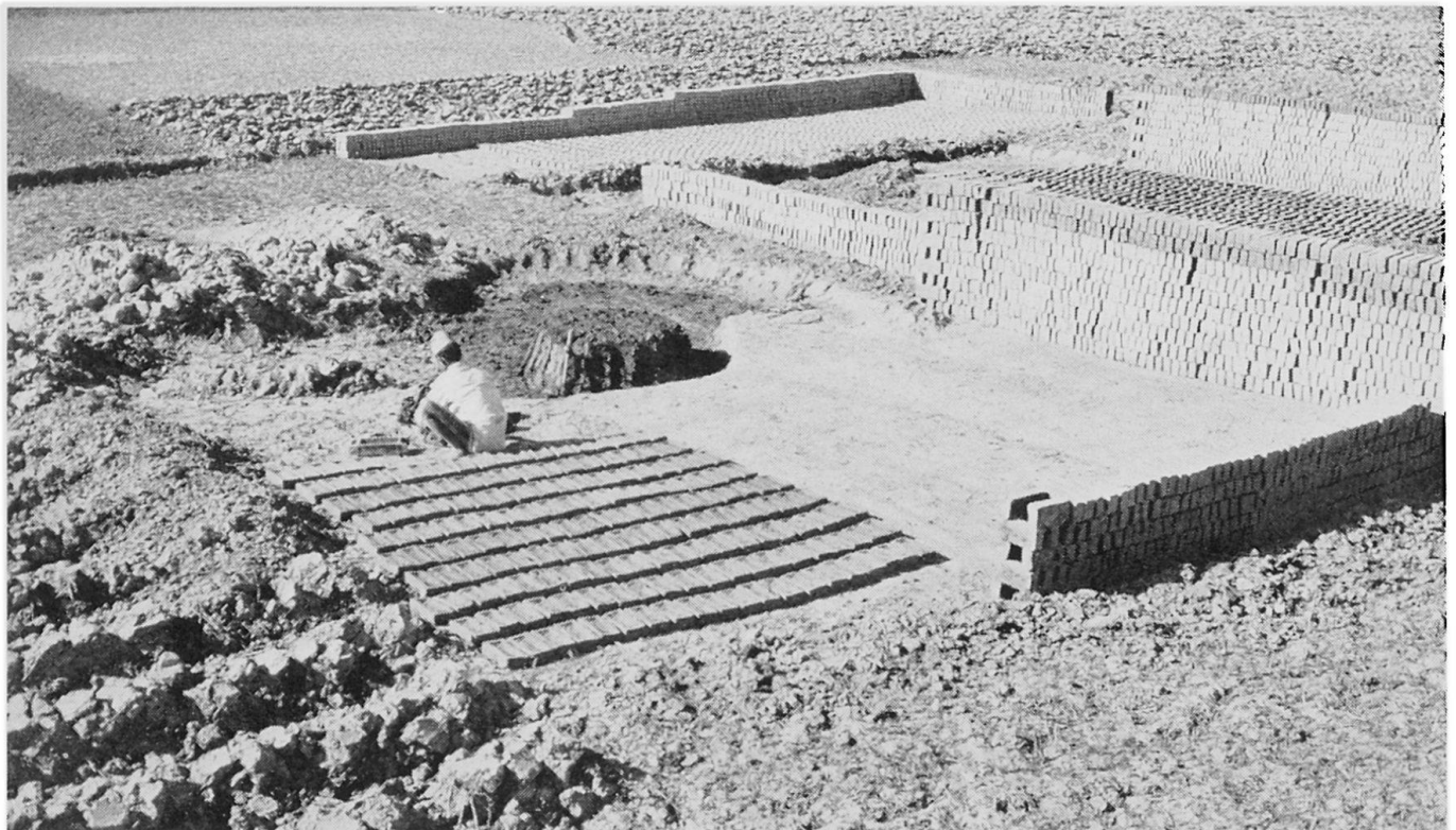
Abbildung 5. Rohmaterial für Ziegelherstellung . Das Abstechen des Reisfeldes ist im Text beschrieben. Der Arbeiter mischt an Ort und Stelle den Lehm mit Wasser, preßt die Masse in Formen und legt die Rohziegel zum Trocknen (Bildmitte) aus. Vorne rechts ein Brachfeld, welches Reis trug; links vorne Stück eines Feldes mit Winterkulturen. – Aufnahme HB März 1968
