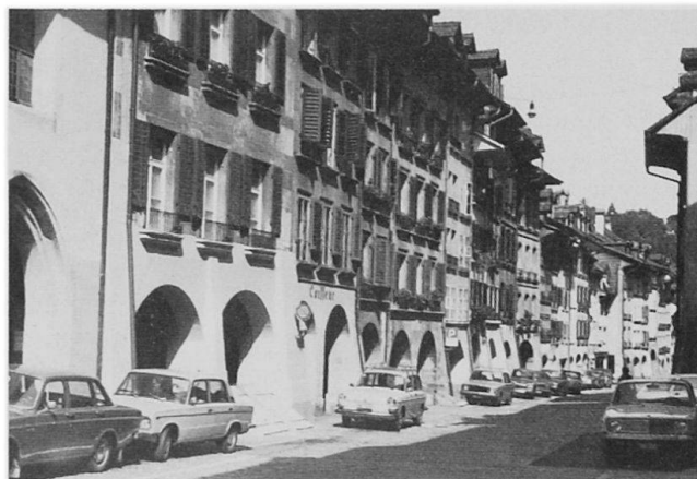
Abb. 5: Weißes Quartier-Nord. Nördliche Häuserreihe an der Postgasse, Blick gegen Osten. Links angeschnitten das Antonierhaus (Postgasse 62, ehemalige Kirche des Spitalordens der Antoniter, 1492–1505 erbaut). Aufnahme Dr. E. Gächter, Sept. 1977.
