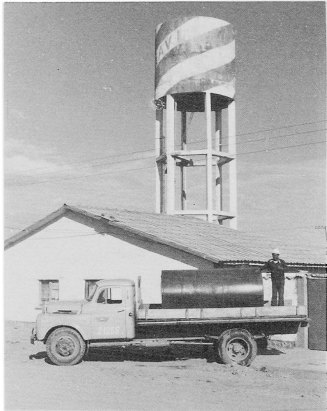
Abb.2 Zisternenwagen und Wasserturm, die den Stadtteil CONAVI Rio Seco (76.5/84.5) mit Trinkwasser versorgen.
