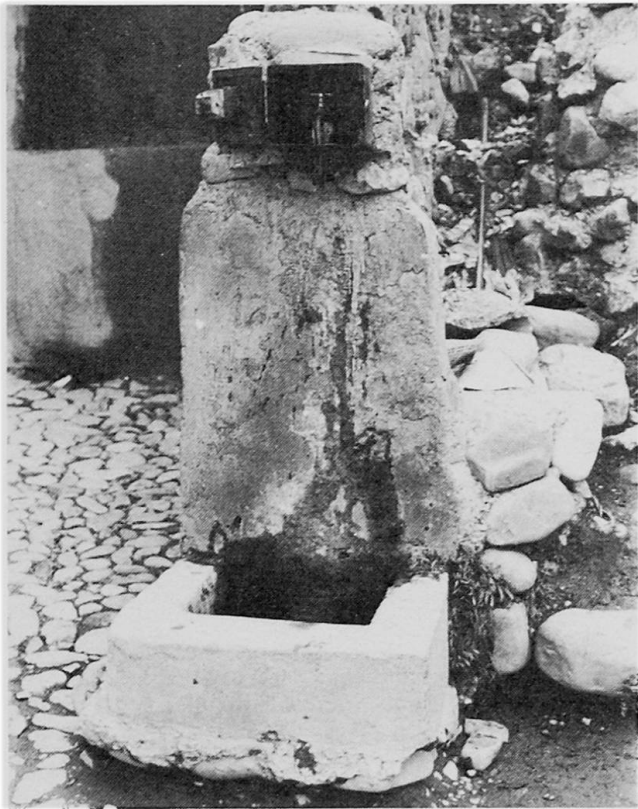
Abb.1 Öffentlicher Brunnen mit Schließkasten, 1,5 km nördlich der Plaza San Francisco (77.5/92.5).
