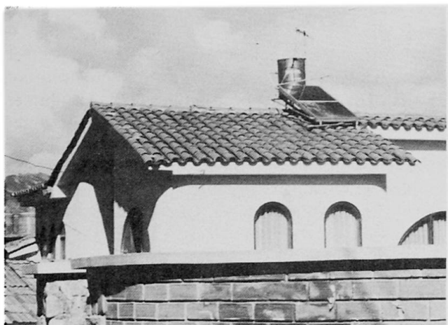
Abb. 5 Auf diesem Haus in Achumani (73.5/100) sind ein Faß als Reservetank und ein Sonnenkollektor angebracht.
