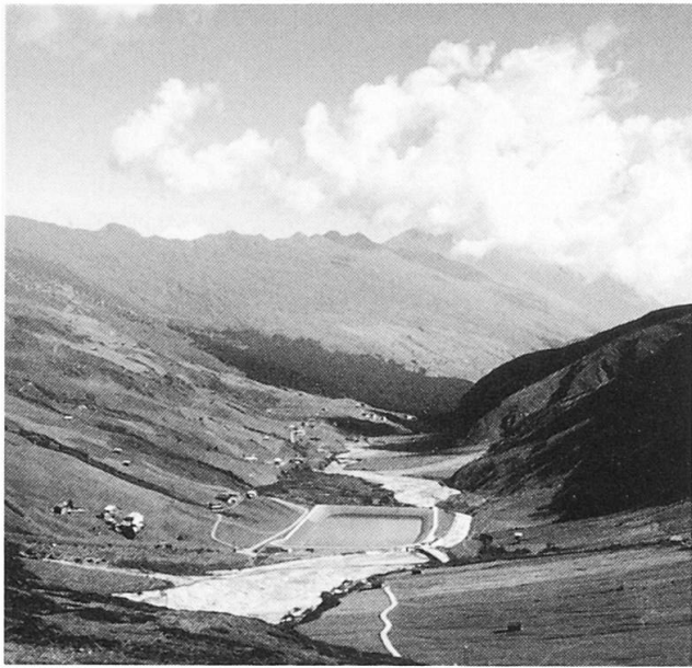
Abb. 3 Das Ausgleichsbecken der Kraftwerke Zervreila AG kann als Symbol des wirtschaftlichen Aufschwungs der Gemeinde Safien seit den 50er Jahren gelten. Steuereinnahmen aus der Wasserkraft verhinderten die Entfaltung eines «harten» Tourismus – heute könnten die unästhetischen Eingriffe in die Landschaft die Ausbreitung eines sanften Tourismus beeinträchtigen. (Aufnahme: D. Peter 1991)
