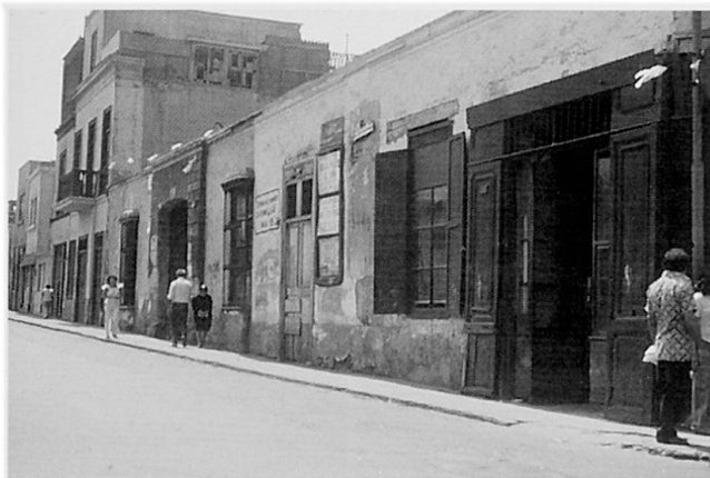
Abb. 2 Tugurios im Zentrum Limas in den 80er Jahren. Die Bauten stammen aus den 30er Jahren. Der Verputz blättert ab, das Innere verfügt nur über einen einzigen Wasserhahn für über 50 Personen (siehe Karte im Atlas S.148).
