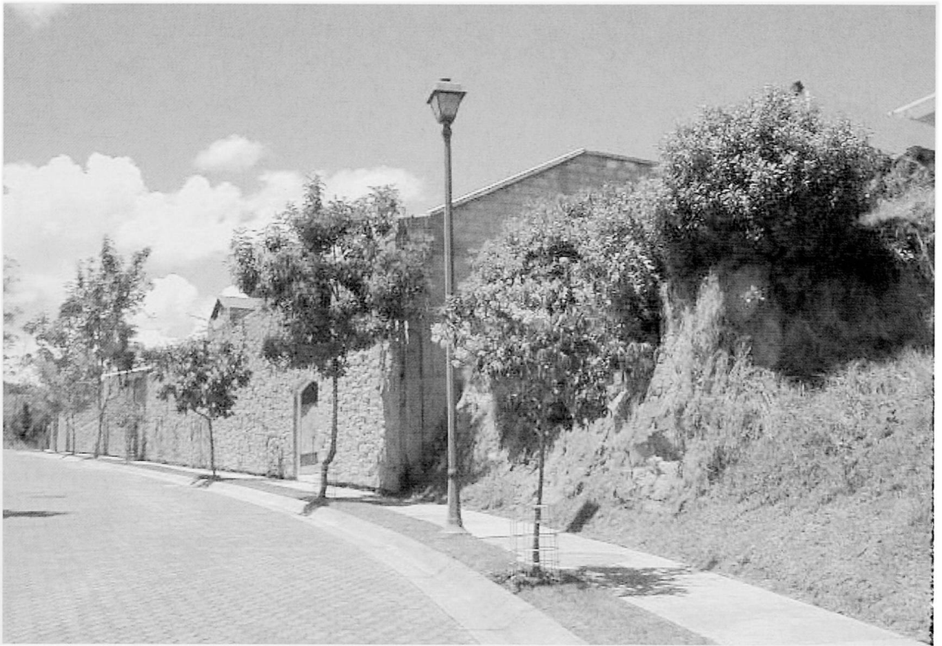
Foto 2: Mauern innerhalb der urbanización Altos del Valle in Quito Walls within the «urbanización» Altos del Valle in Quito Murs à l'intérieur de l'«urbanización» Altos del Valle en Quito
