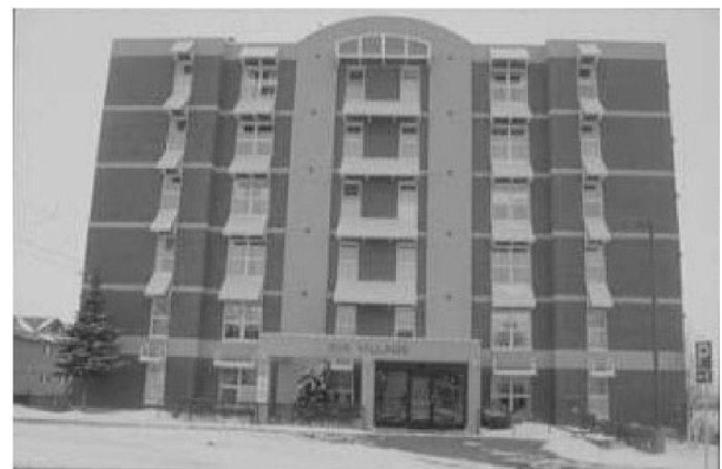
Fig. 3: Non-profit housing Logements sans but lucratif Gemeinnütziger Wohnungsbau Photo: W. HORNE
