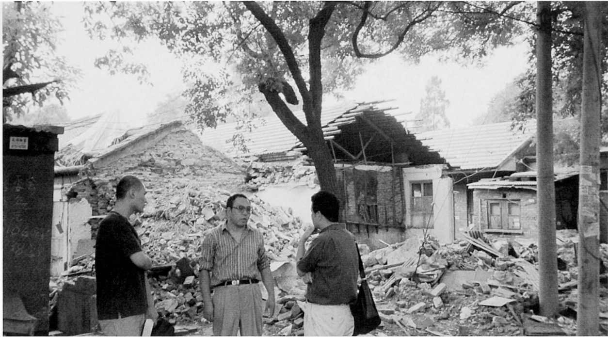
Photo 2: Un hutong détruit dans une zone de préservation du patrimoine
