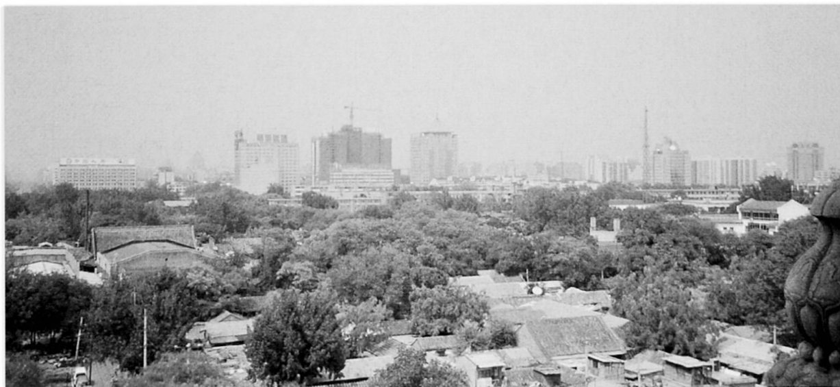
Photo 1: Elimination de vieilles structures par le développement urbain moderne
