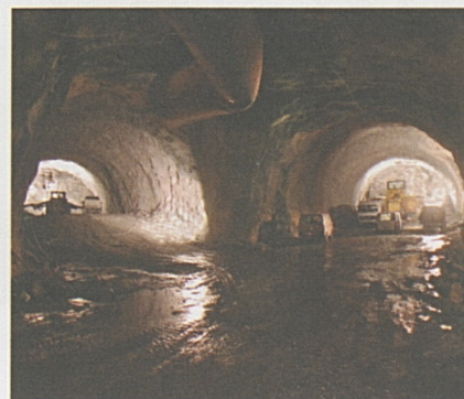
In Faido in der Leventina läuft zurzeit der Ausbruch der Multifunktionsstelle.
