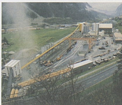
Auf der Neat-Baustelle in Amsteg wird rund um die Uhr gearbeitet.
