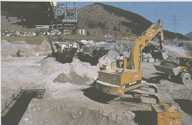
250 000 Tonnen bautechnisch nicht geeignetes Material werden vom Val da Claus..... ins Val Bugnei umgelagert.
