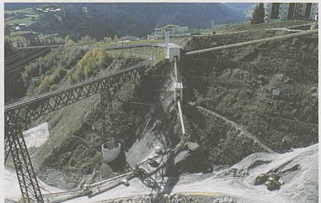
250 000 Tonnen bautechnisch nicht geeignetes Material werden vom Val da Claus..... ins Val Bugnei umgelagert.
