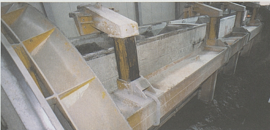
In der Kippstelle werden die Schutterwagen mit einem Rotationskipper entleert.
