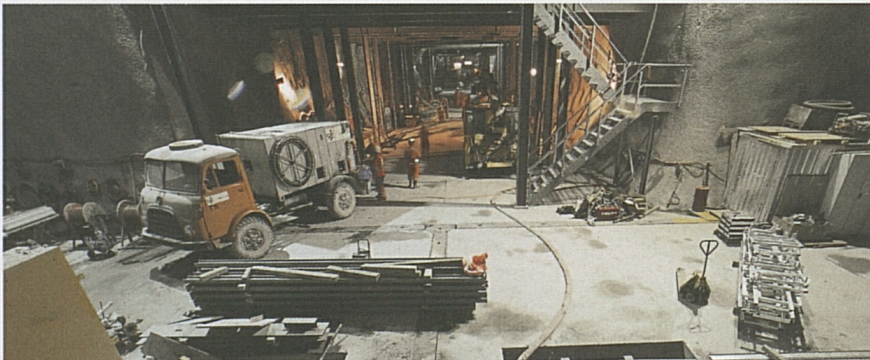
Links: Auch in der Querkaverne 2 am Schachtfuss wird rund um die Uhr gearbeitet.
