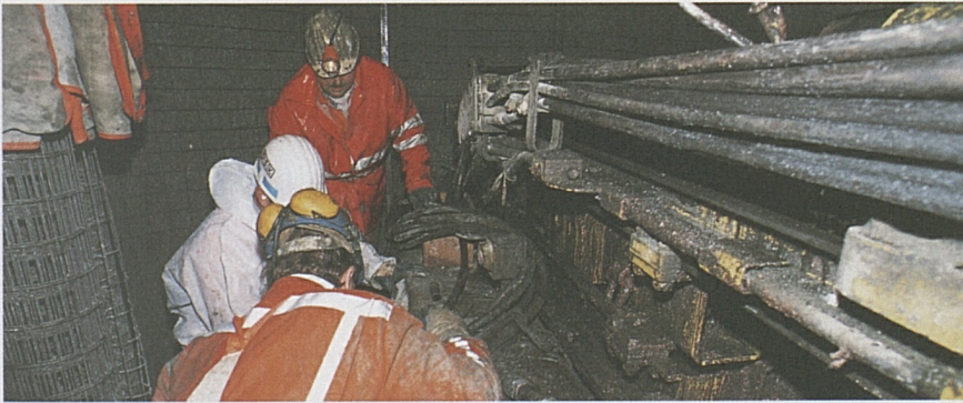
Mineure beim Ankerversetzen im Schacht II.
