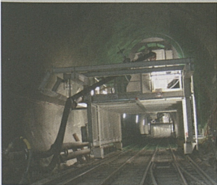
Oströhre des Gotthard-Basistunnels in Bodio.
