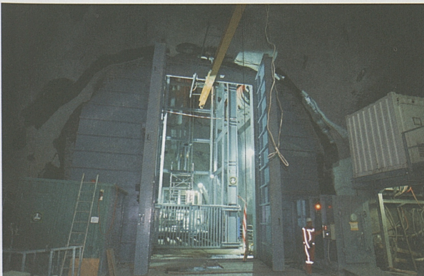
Der zweite Vertikalschacht von Sedrun ist mit ...
