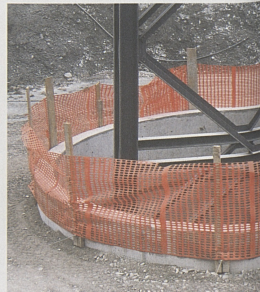
Stützpfiler der Eisenbahnbrücke im Val Bugnei.
