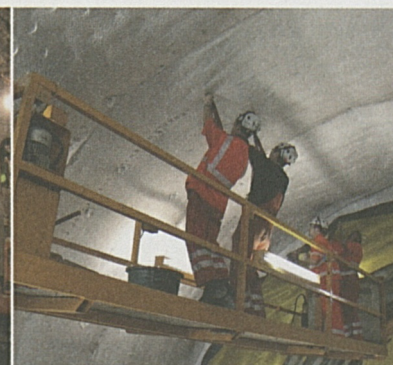
Bodio – Mineure beim Befestigen von Abdichtungsmatten in der Oströhre.
