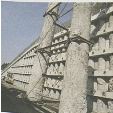
Erstfeld – Im Voreinschnitt werden bald die Tunnelbohrmaschinen montiert.
