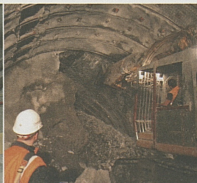
Faido – Durchschlag in der Weströhre der Multifunktionsstelle.
