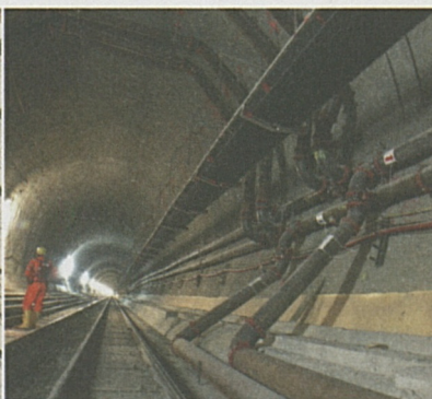
Amsteg – Blick in die Weströhre mit Förderband und Kühlwasserleitungen.
