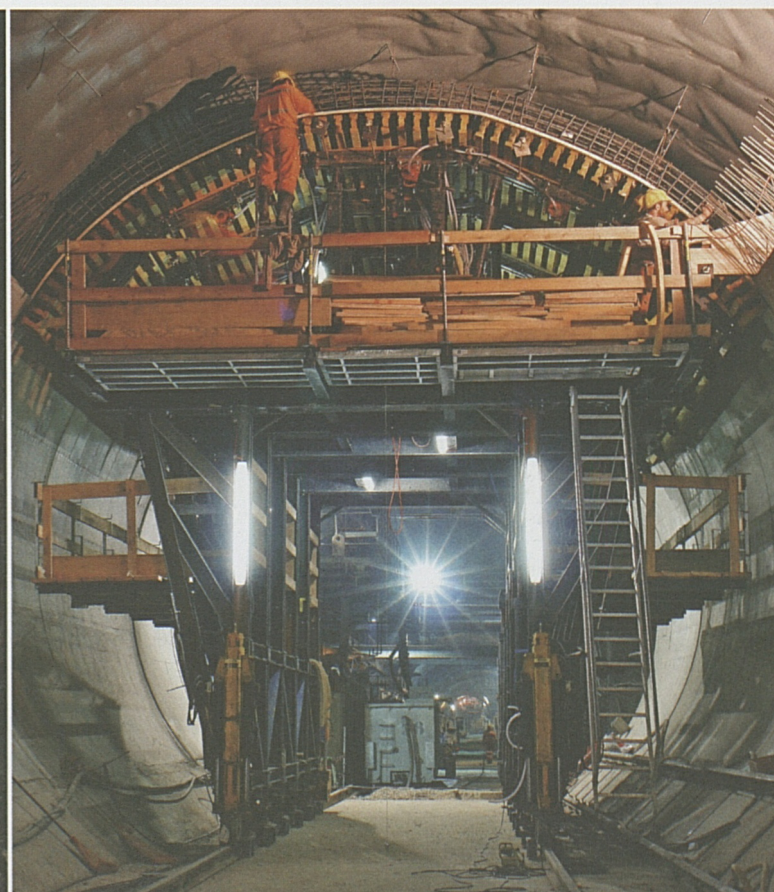
Betonarbeiten in der Multifunktionsstelle.
