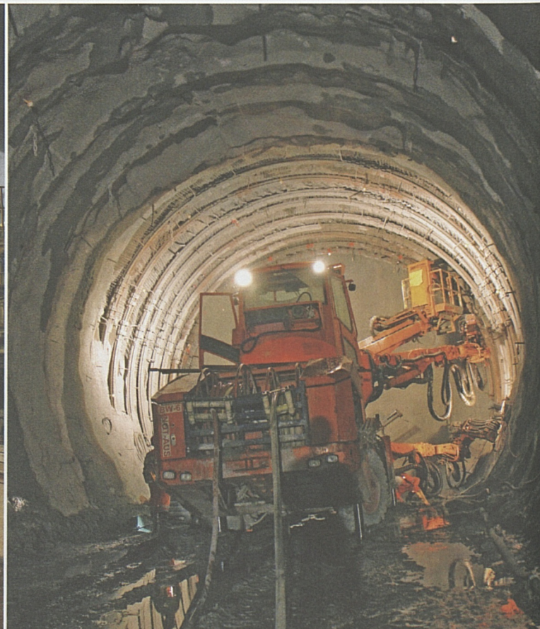
Südvortrieb: Fellsicherung in der Weströhre Richtung Süden.
