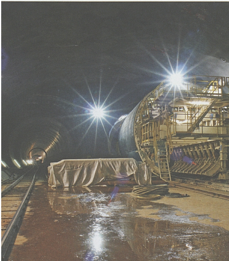
Weströhre mit neu montiertem Schalwagen für die Innenschale.
