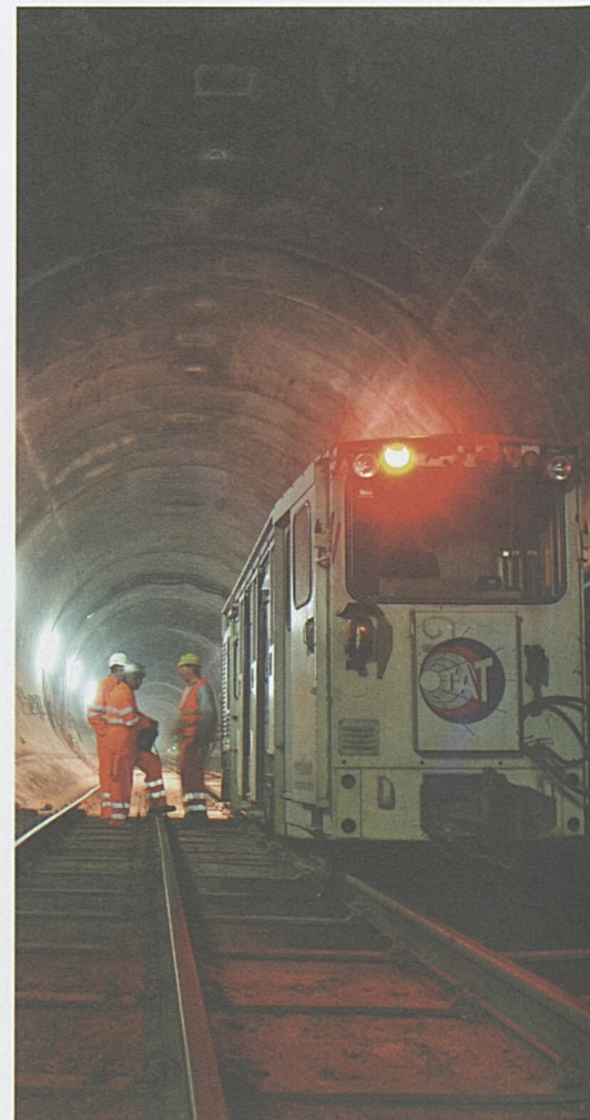
Bodio – Weströhre mit Stollenbahn und Mineuren.
