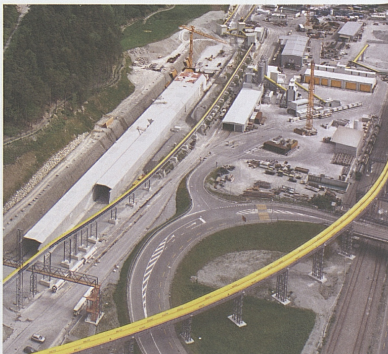
Tagbautunnel in Erstfeld.
