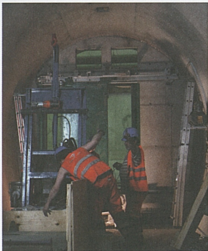
Amsteg: Einbau einer Querschlagstür.
