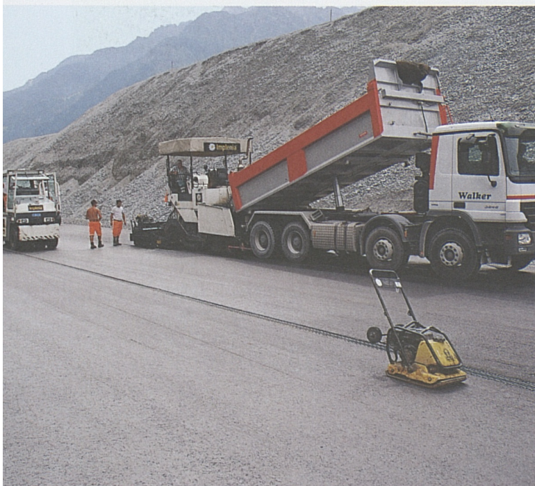
Altdorf/Rynächt: Belageinbau auf offener Strecke.
