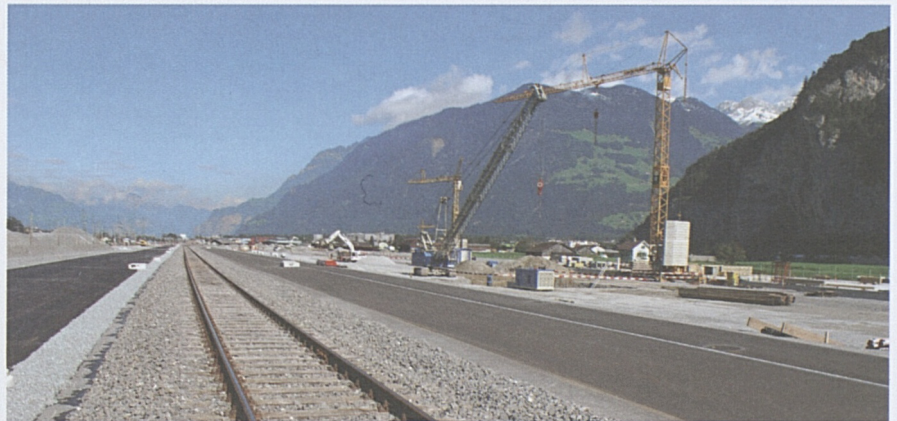
Bahntechnikinstallationsplatz Rynächt: Rohbauarbeiten für die temporären Gebäude.
