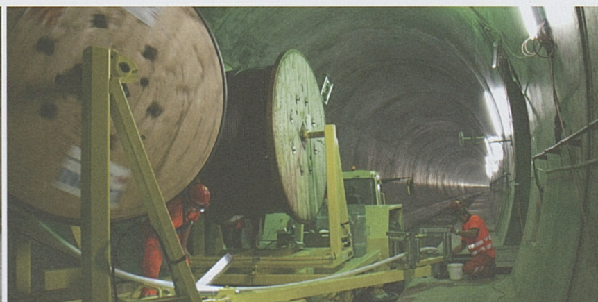
Bodio: Kabeleinzug in der Weströhre.
