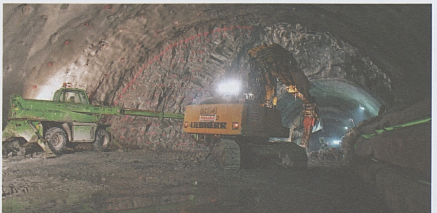
Erstfeld Weströhre Verzweigungsbauwerk: Die letzte Sprengung ist erfolgt und der Ausbruch abgeschlossen.
