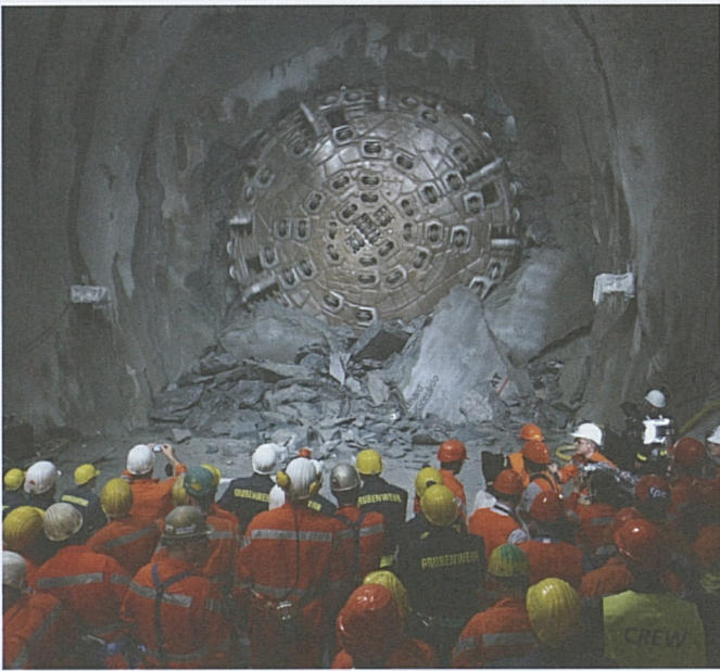
Kurz nach dem Durchbruch: Der glänzende Bohrkopf stösst die letzten Felsblöcke aus dem Weg.
