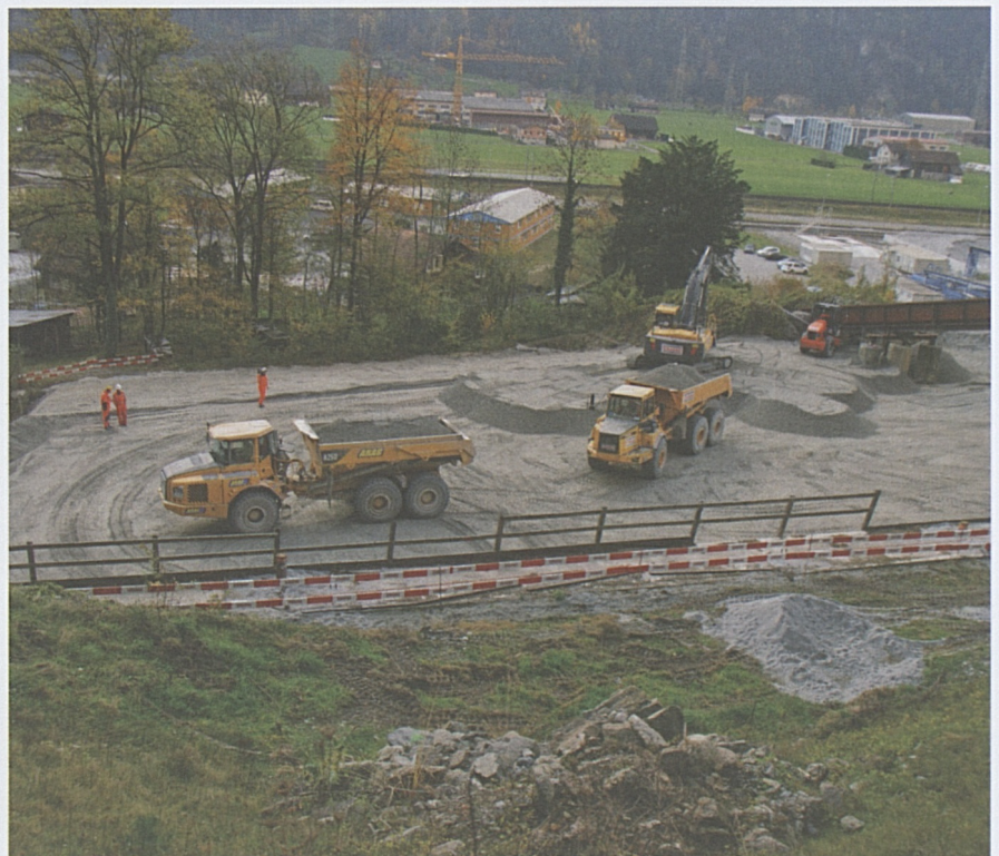
Erstfeld: Der Voreinschnitt mit dem Tagbautunnel wird mit Ausbruchmaterial zugeschüttet.
