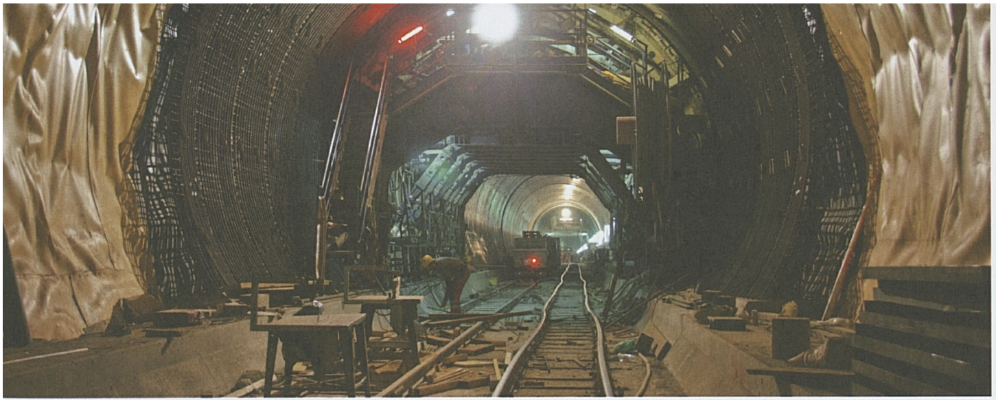
Erstfeld/Amsteg: Vorbereitung für die Betonierung der letzten Meter Tunnelgewölbe vor dem Zusammenschluss.
