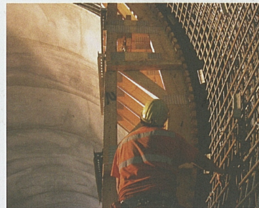
Aufwendige Betonierarbeiten in den Tunnelröhren.
