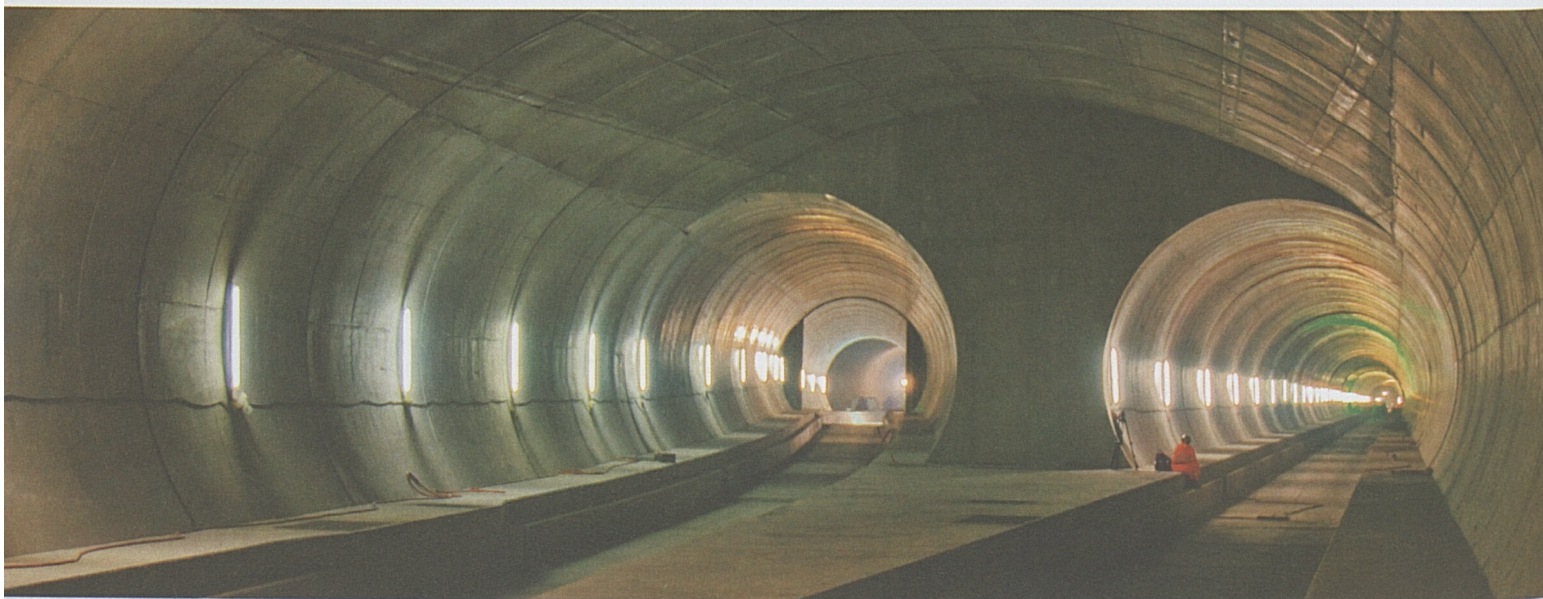
Oben: Die Demontage der letzten Tunnelbohrmaschine zwischen Sedrun und Faïdo. Unten: Im Rohbau fertiggestellter Spurwechsel in der Multifunktionsstelle Sedrun.
