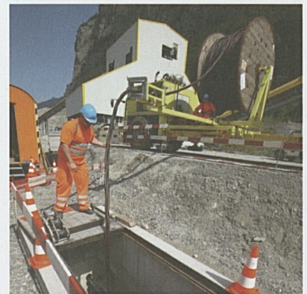
Nordportal Erstfeld: Bereits vor dem Tunnel müssen Kabel für die Bahntechnik eingezogen werden.
