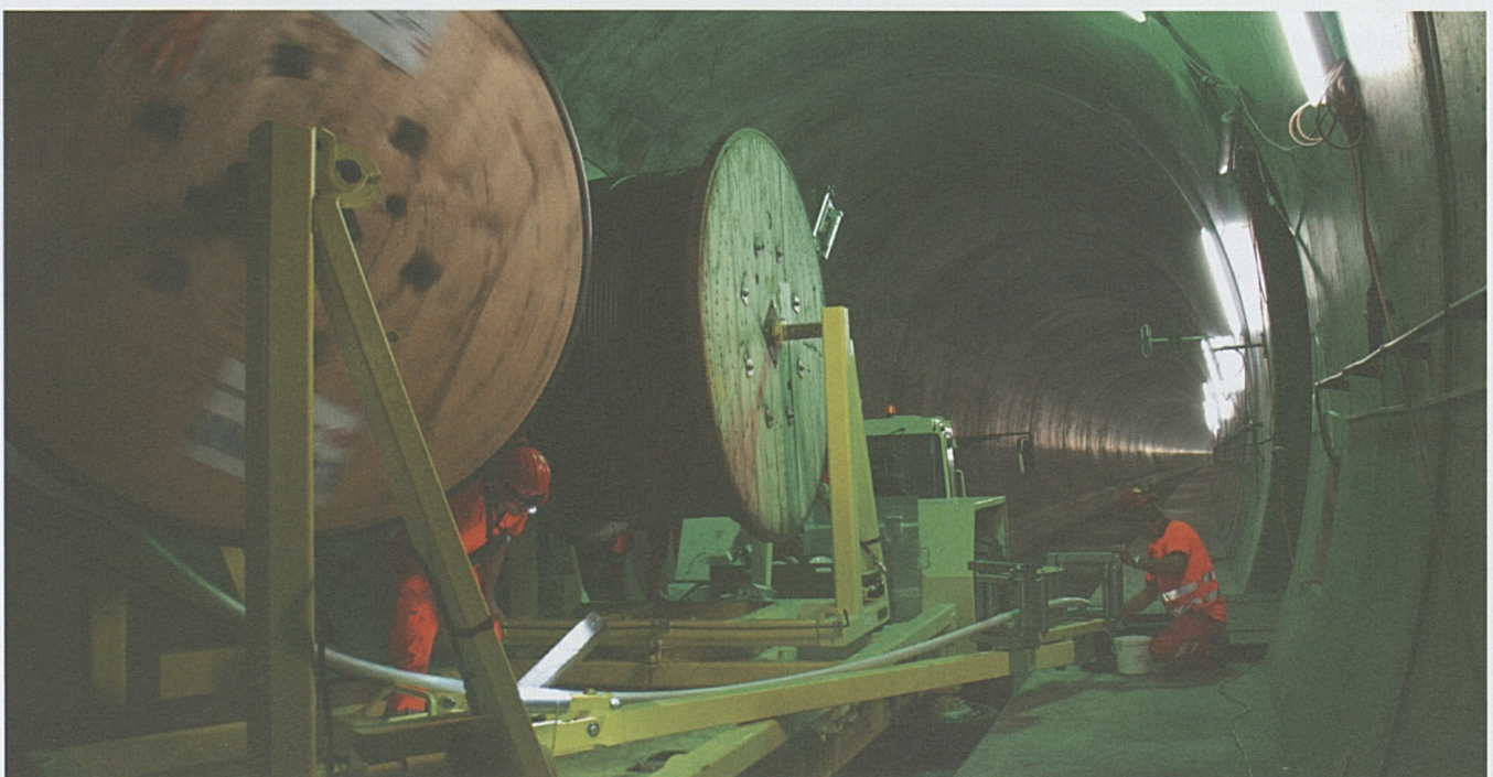
Eine der ersten Arbeiten der Bahntechniker: Der Kabeleinzug in den Tunnelröhren.
