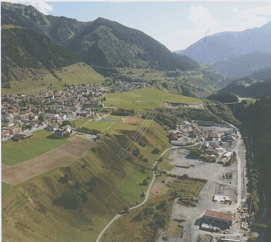
Das Baustellendorf und der Installationsplatz sind zurückgebaut (links). Die Standseilbahn in Sedrun hat ihren Dienst getan (rechts).
