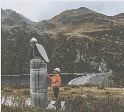
Zehn GPS-Geräte überwachten während 14 Jahren das Gelände um Sedrun. Heute sind es noch zwei.
