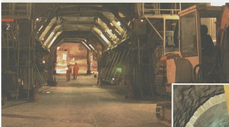
Due fasi dei lavori alla discenderia di Polmengo. Sopra: il cassero ai piedi della discenderia. A destra: il tubo per la ventilazione.
