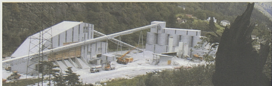
L'impianto già in funzione per il trattamento degli inerti, con il quale è possibile riutilizzare parte del materiale di scavo della galleria.
