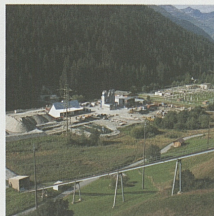
A causa della geologia più difficile a Sedrun l'avanzamento avverrà mediante brillamento.
