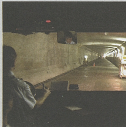
La SUVA ha certificato un'eccellente sicurezza sui cantieri AlpTransit.
